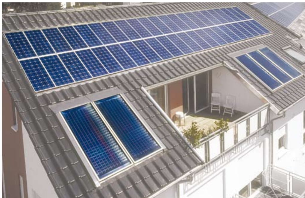
Combinaison REHAU SOLECT et système photovoltaïque sur le même toit.
